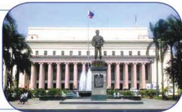
Bangunan Parlimen, Manila
