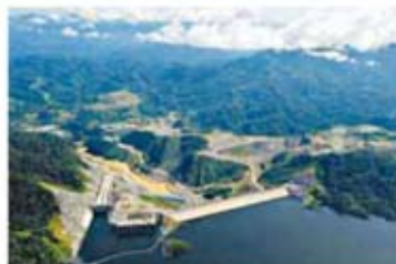
Gambar foto 3.5 Stesen jana kuasa hidroelektrik Bakun
