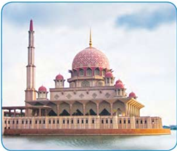
Masjid Putra, Putrajaya.
