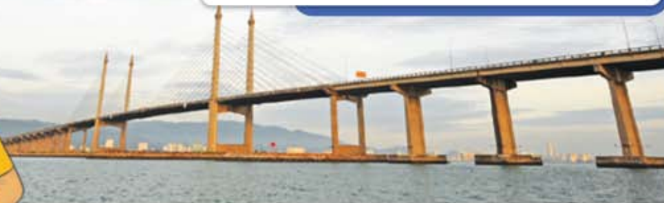
Jambatan Pulau Pinang
