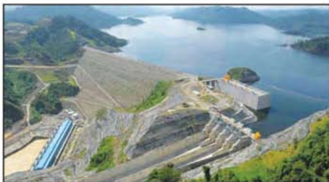
Empangan Bakun, Sarawak
