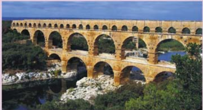
Akueduk di Pont Du Gard, Perancis.
