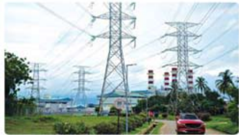
Kabel penghantaran arus ulang-alik pada 132 kV di stesen jana kuasa Tanjung Kling, Melaka.
